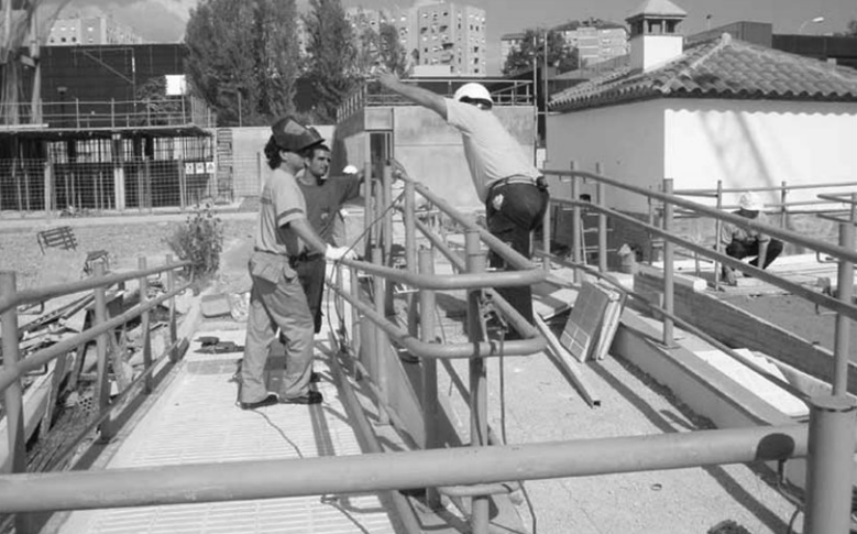
Construyendo una rampa
