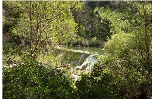
Azud de l'Infern, el de mayor altura del estrecho.
